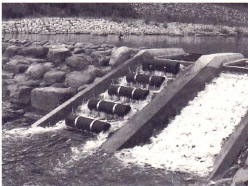
Gambar 11 Tangga ikan ( Fish Way ) sebagai alur ruaya ikan sidat pada bagian sungai yang di bendung
