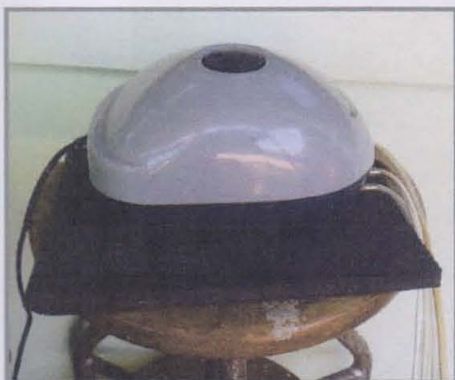
Gambar 5.7. Pemasangan Blower dan Proses Aerasi Tandon Penampung Cadangan Air
