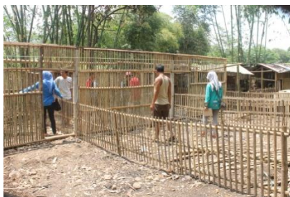
Gambar 9. Proses Perbaikan Kandang
