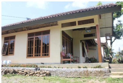
Kondisi Rumah Warga
