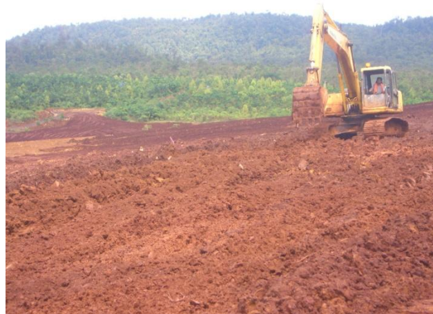
Gambar 2. Penggemburan kembali tanah padat dengan excavator
