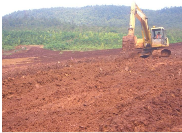
Gambar 2. Penggemburan kembali tanah padat dengan excavator
