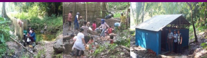
Pembangunan Kamar Mandi Umum di Desa Depok
