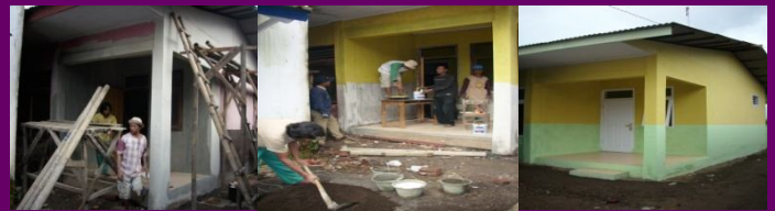
Renovasi gedung serbaguna & Perpustakaan
