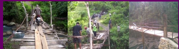
Renovasi jembatan Di Kampung Ciakar
