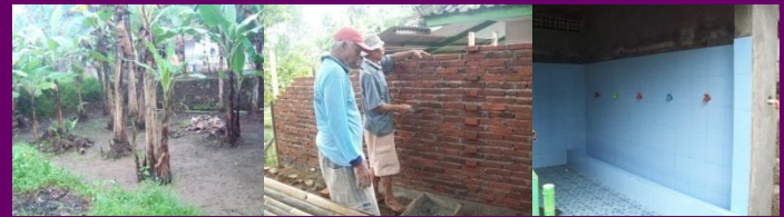
Pembuatan WC dan Tempat wudhu
