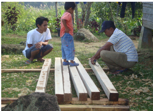
m. Pembangunan Saung Baca
