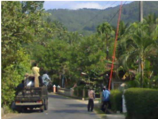
Lampiran 2. Proses perbaikan jaringan listrik di pedesaan
