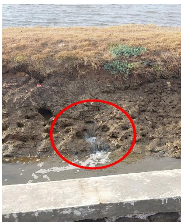
Gambar 23 Tambak mengalami kebocoran (Sumber: Dokumentasi peneliti 2023)
