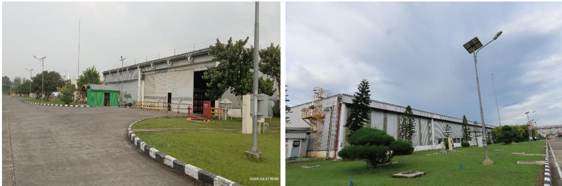
Gambar 5 Kondisi flora Blok Gudang
