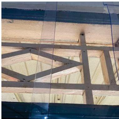
Gambar 21 Kondisi ventilasi di sarana produksi UMKM Dapur Umak setelah dilakukan perbaikan penerapan CPPOB
