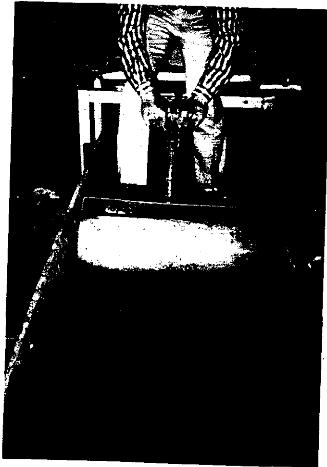
Gambar 44. Pemadatan tanah dengan roda pemadat.
