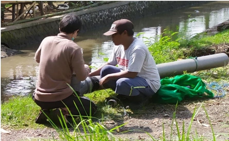
Gambar 23. Pemasangan komponen Elektronika Pikohidro
