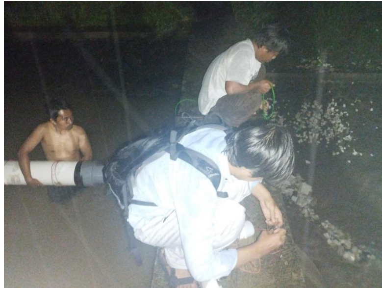
Gambar 24. Pemasangan bangunan pikohidro untuk pengujian
