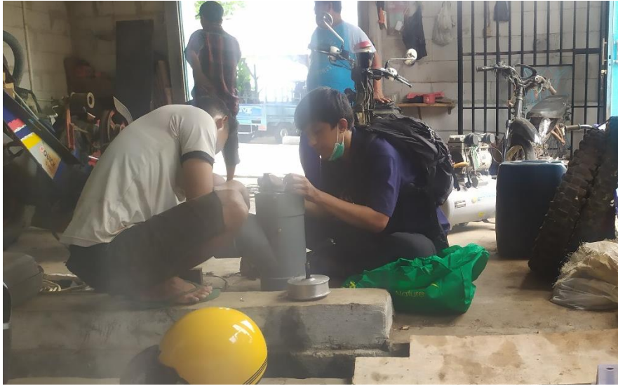
Gambar 22. Pemasangan Trasmisi, Turbin, dan Generator
