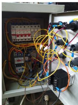
Gambar 50 Sitem kelistrikan pada kontrol panel SRO
