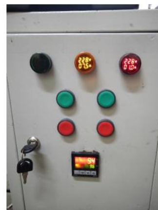
Gambar 50 Sitem kelistrikan pada kontrol panel SRO
