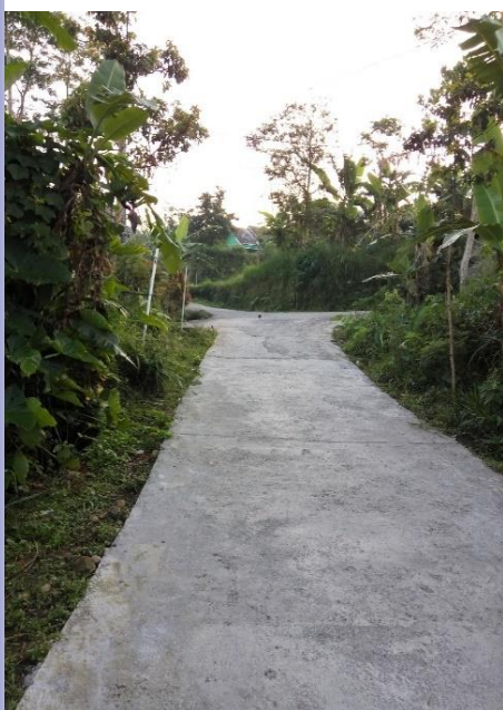
Gambar 3 Jalan Aspal di Dusun Kalitengah Lor
