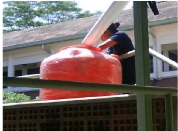
Gambar 2. Pemasangan penampungan air sementara.
