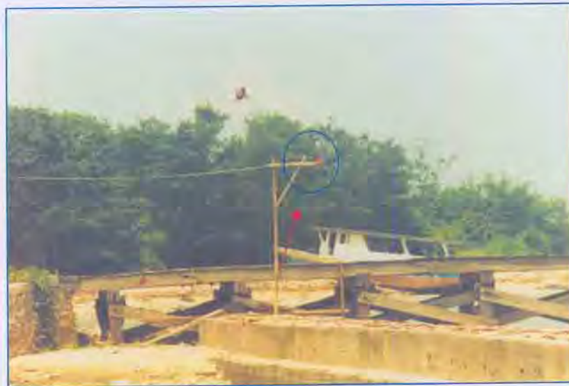
Gambar 6. Anemometer yang dipasang di dermaga SM. Pulau Rambut
