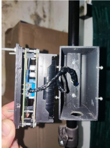
Gambar 25 UPS Sistem Sebagai Daya Cadangan
