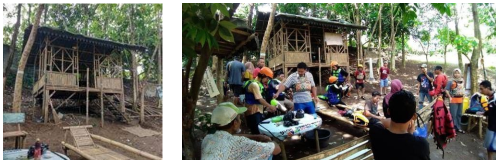
Gambar 7 Pos Pantau KPC Jakarta selesai dibangun Sumber: Dokumen KPC Jakarta
