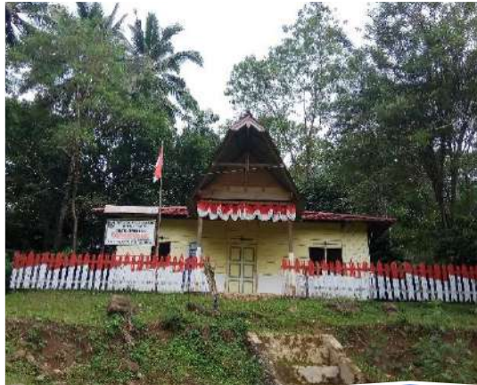
Gambar 19. Kantor Desa Bakadisura , Kecamatan Tabang
