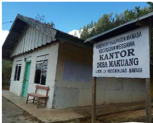
Gambar 15. Kantor Desa Makuang, Kecamatan Messawa
