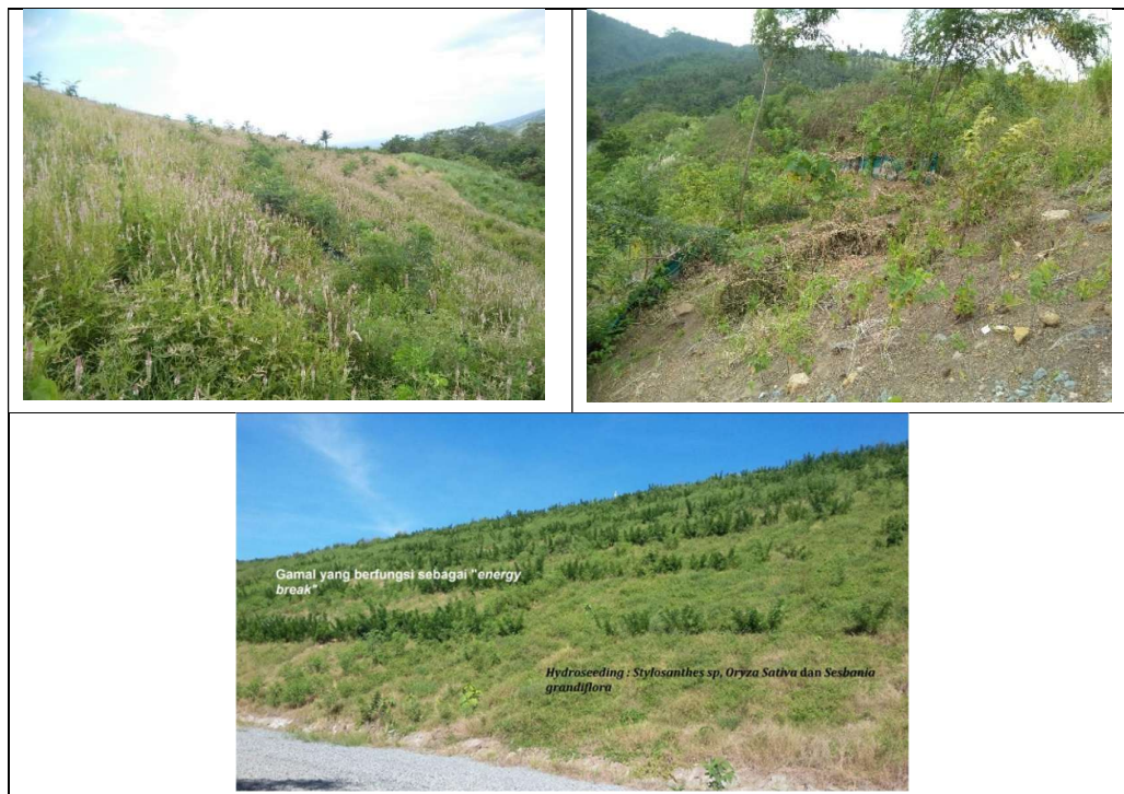
Gambar 11. Tanaman pagar ( Gliricidiae -gamal) ditanam secara berbaris memotong lereng menjadi water flow breaker ( energy breaker ) sebagai bentuk usaha pengendalian erosi (Foto oleh Tejo Baskoro)
