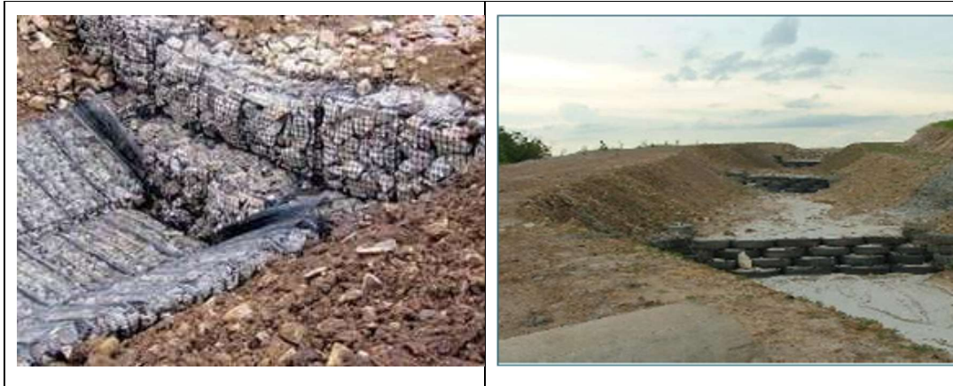
Gambar 18. Dam pengendali dengan bronjong (gabionsupply.com) dan dengan menggunakan ban bekas (Foto : Agus Subandrio)
