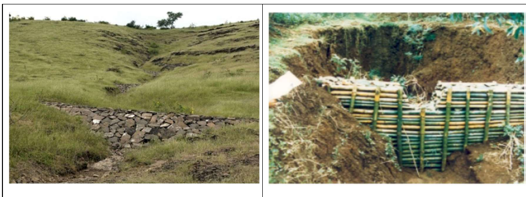
Gambar 17. Gully plug dari batu yang disusun dan dari bambu
