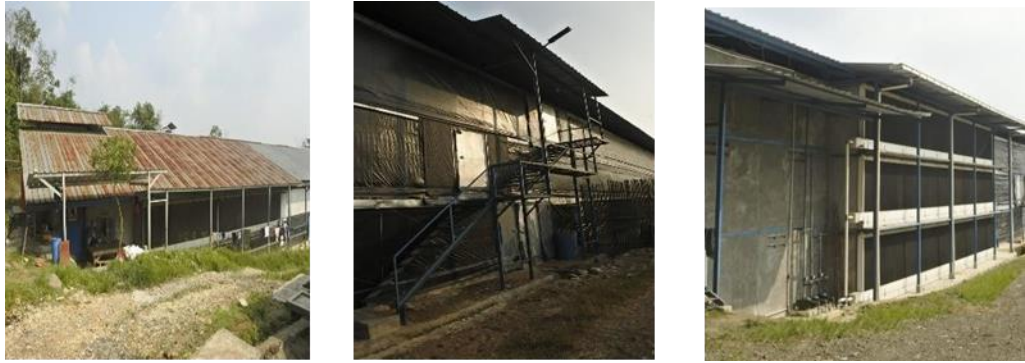
Gambar 5 Atap Kandang, Dinding Kandang, dan Cooling Pad
