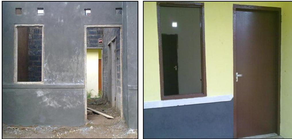
**Gambar 12.** Hasil Pemasangan Kusen Beton Setelah Dicat
