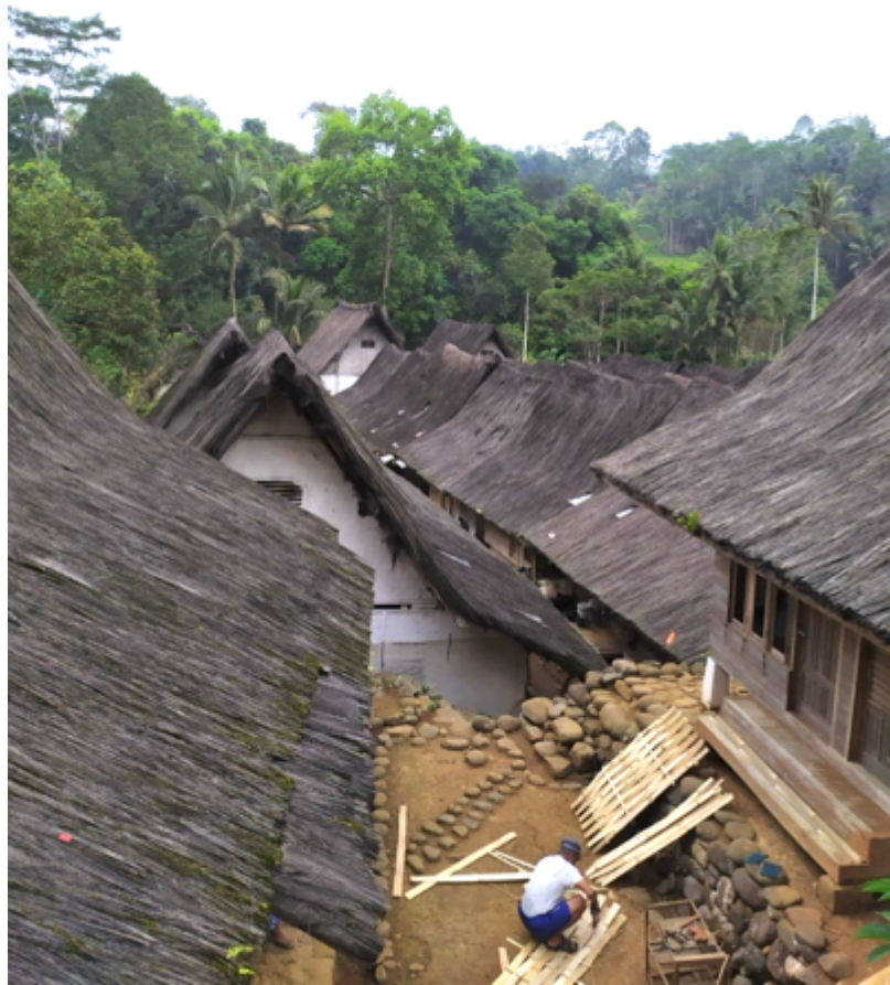
Gambar 20 Keteraturan atap rumah di Kampung Naga Desa Neglasari
