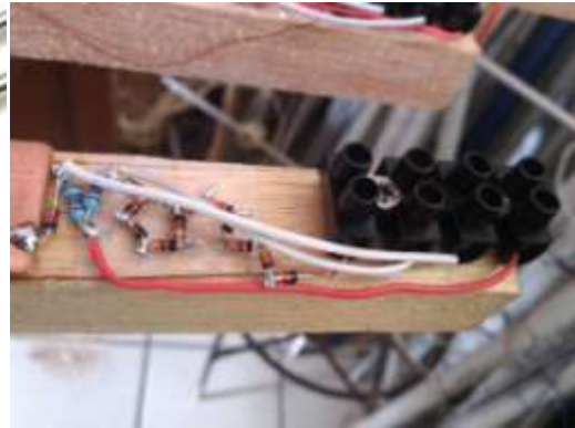
Pemasangan rangkaian Solarimeter
