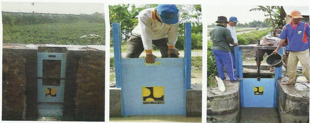
Gambar 8 Uji Coba Penerapan Pintu Fiberglass : (a) BCMK 23 Ki (Di Cimanuk, Garut); (b) Sub-Sekunder Gabus (Sekunder Kandang Haur, Di Jatiluhur, Patrol)
