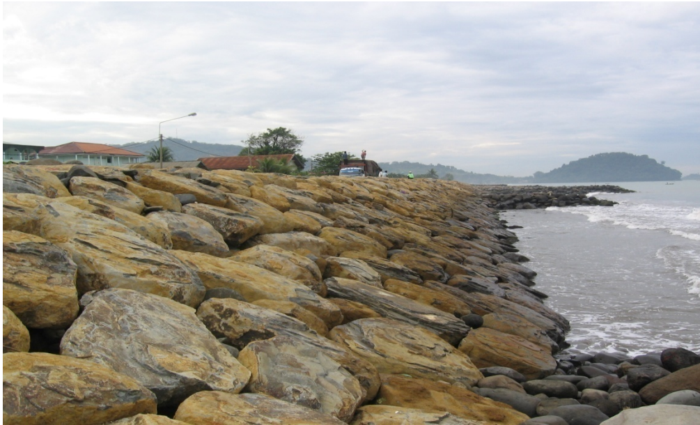
Gambar 5.4. Seawall Pantai Padang, Kota Padang
