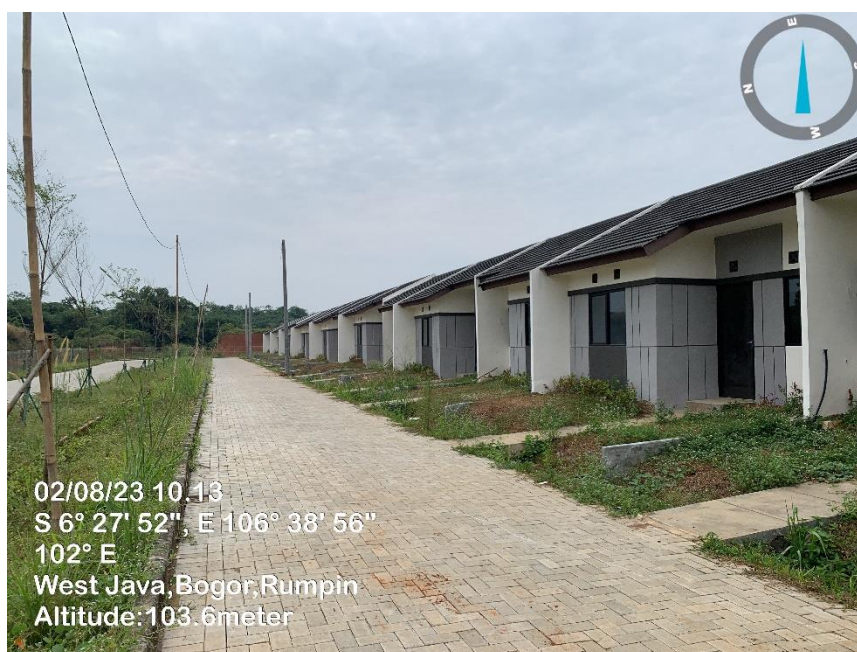
Gambar 1 Kondisi Eksisting Perumahan Argasatya
