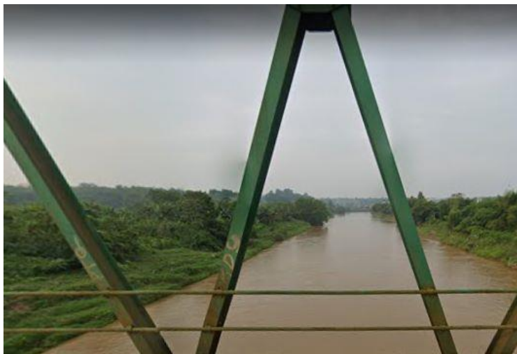
Gambar 17 Kondisi Eksisting Sungai Cisadane di Wilayah Kajian
