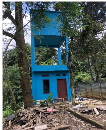
Sumber air: sumur bor dan pipanisasi saluran rumahtangga
