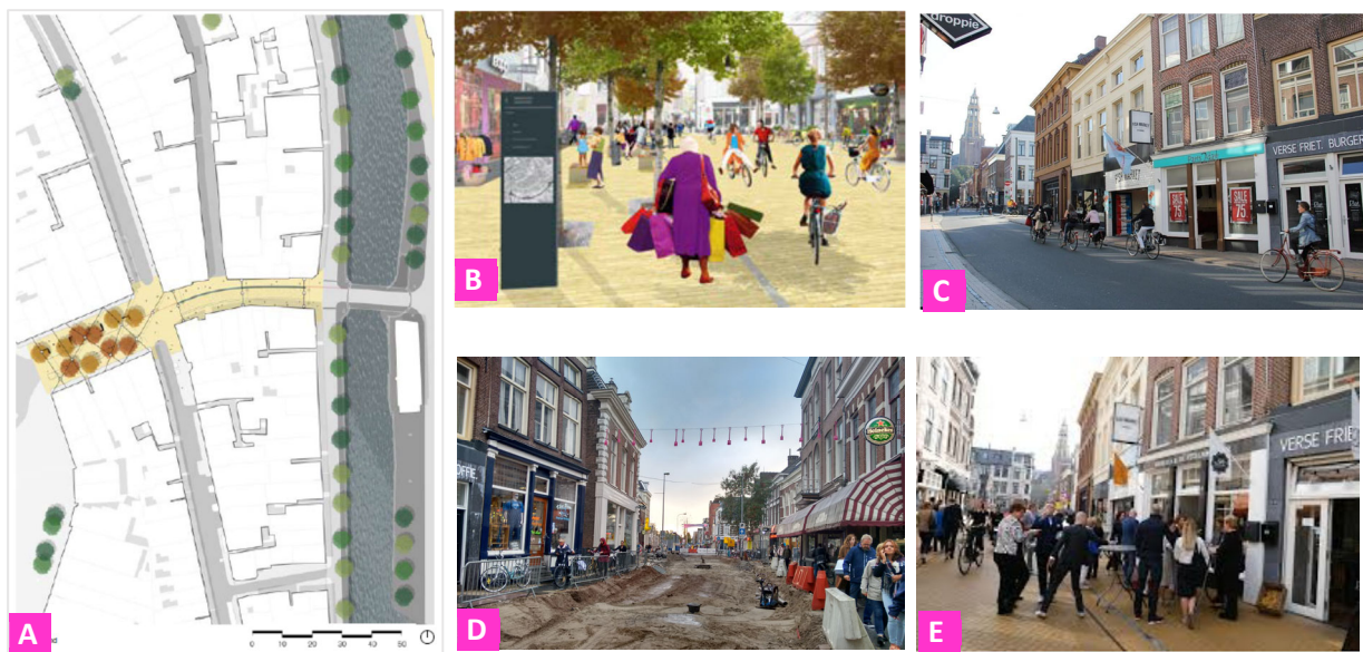
Gambar 6. (A) dan (B) merupakan gambar redesain A-sstraat (sumber: ruimtevoorjou.groningen.nl )), (C) merupakan kondisi awal A-sstraat sebelum proyek berjalan (sumber: google.com ), (D) menggambarkan kondisi pekerjaan pembongkaran jalan aspal (Sumber: penulis), dan (E) suasana A-sstraat setelah proyek selesai dimana pengguna jalan dan pesepeda leluasa bergerak dan pengunjung toko lebih ramai (sumber: google.com ).
