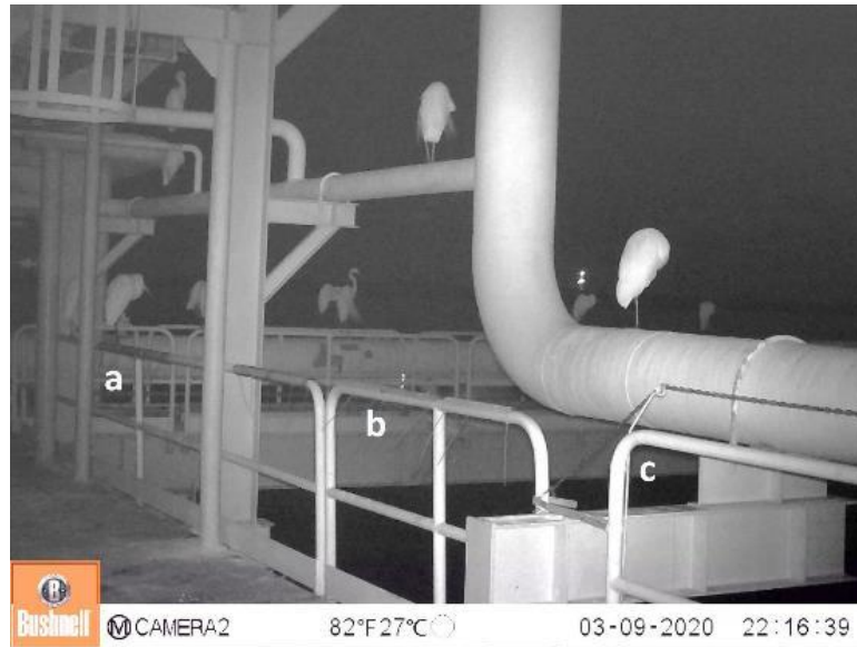
Gambar 20. Efektivitas PDD: (a) kawat loket, yang ternyata tidak efektif dan masih dipakai untuk bertengger, sehingga perlu dimodifikasi, (b) besi siku-kawat loket (tidak ditenggeri), (c) rantai kapal (tidak ditenggeri).
