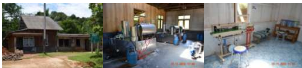
Gambar 11. Bangunan ruang produksi yang telah direnovasi.
