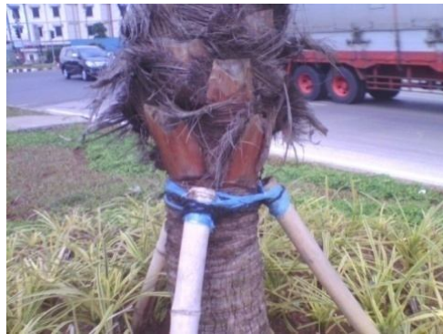
Gambar 7. Penggunaan penyangga dari bambu dengan pengikat rali rafia dan ijuk Lokasi : Traffic Island, persimpangan Bogor Ring Road - Bogor Waktu pengambilan gambar :23 Februari 2010 / 14.30 WIB
