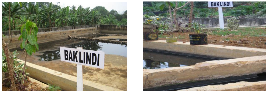
Gambar 1. Bak penampungan lindi di TPA Telaga Punggur, Batam. (Sumber : hijaubatam.files.wordpress.com )
