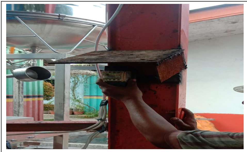
Gambar 49. Pemasangan instalasi kelistrikan sistem bahan bakar
